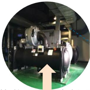
换热温差=冷凝温度-冷却
